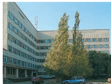
Главный лечебный корпус
