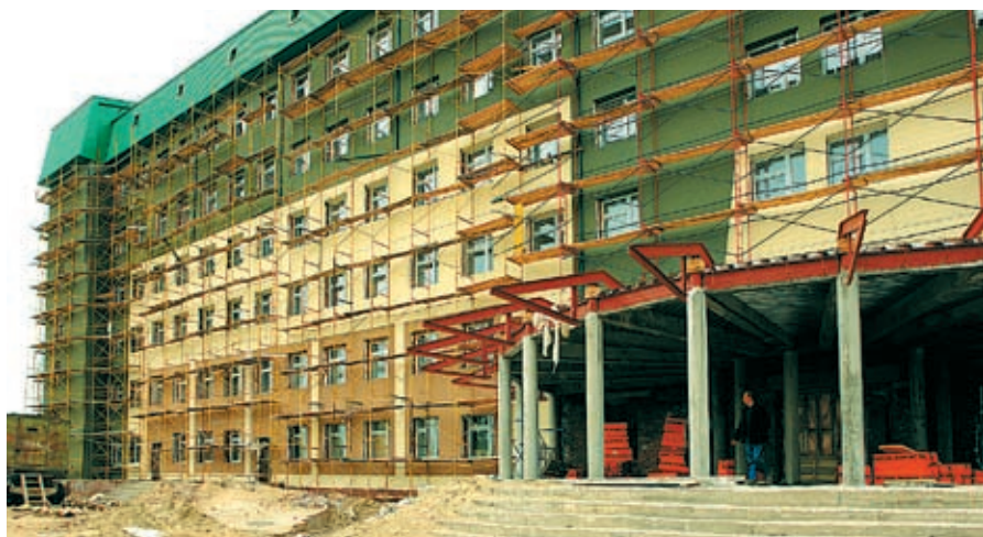
Строительство нового роддома близко к завершению
